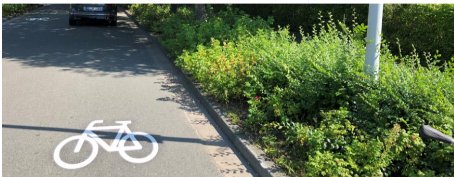
Abbildung 62: Piktogrammreihe auf der Fahrbahn
