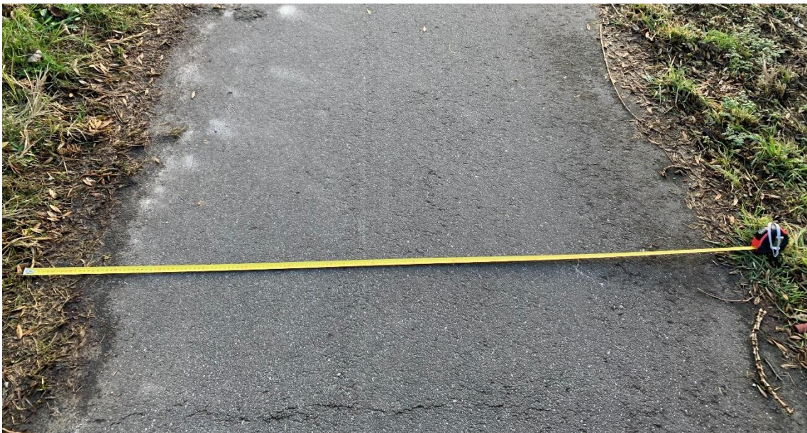
Abbildung 18: Bestandserhebung vor Ort
