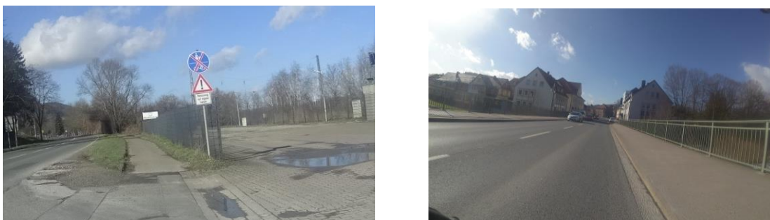
Abbildung 59: Netzlücken im Bestand (links: B3 Godenau/Dehnsen; rechts: Bahnhofstraße)
