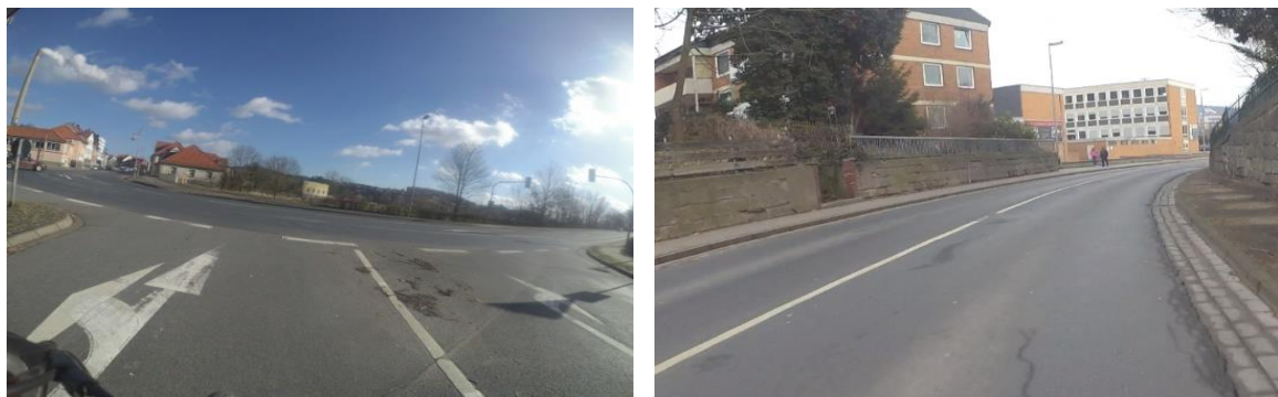
Abbildung 58: Unübersichtliche Fahrbahnverhältnisse Schlehergring
